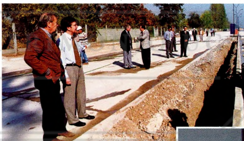
Obra Colector Bilbao
