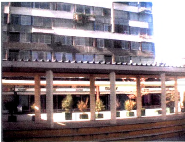
Vista al patio central y parte de la torre C
