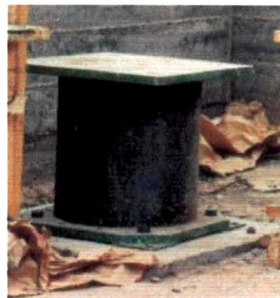
Aislador Sísmico
