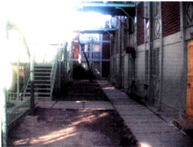
pasillo central de la comunidad
