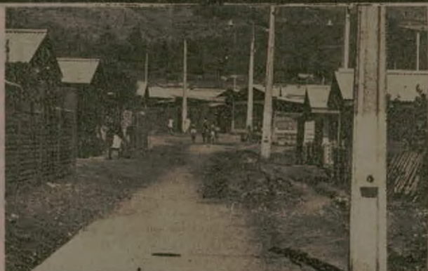
PARECE UN SUEÑO, pero es una feliz realidad: Villa La Reina presenta este aspecto. Casas sólidas, luz, agua, calles pavimentadas, construidas en comunidad. El lema "uno para todos y todos para uno" fue seguido por los vecinos y dio excelentes resultados.
