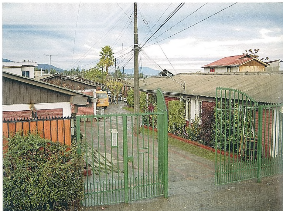
Estado final, espacio público recuperado en Villa la Reina
