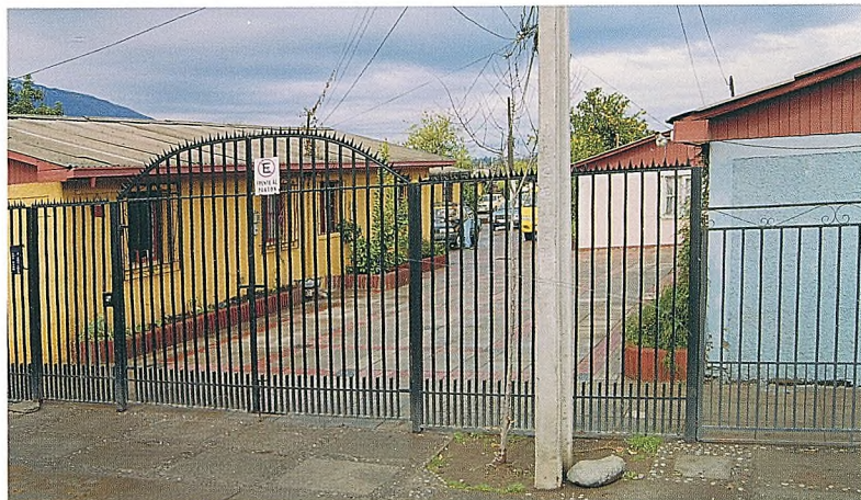
Pasaje después de la intervención
