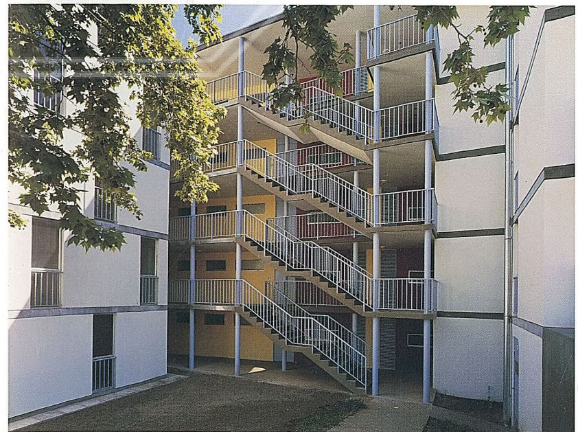
Escaleras de acceso desde el frente poniente
