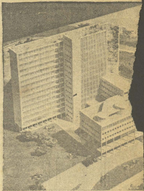
Uno de los modernos edificios que se están construyendo en São Paulo, destinado a Maternidad del Estado.
