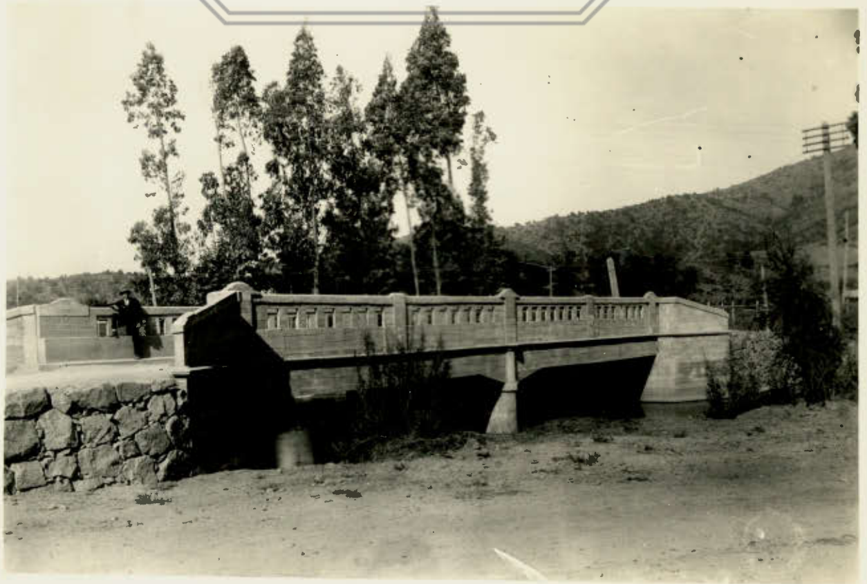
Ubicado en camino de Valparaiso a Casablanca.
