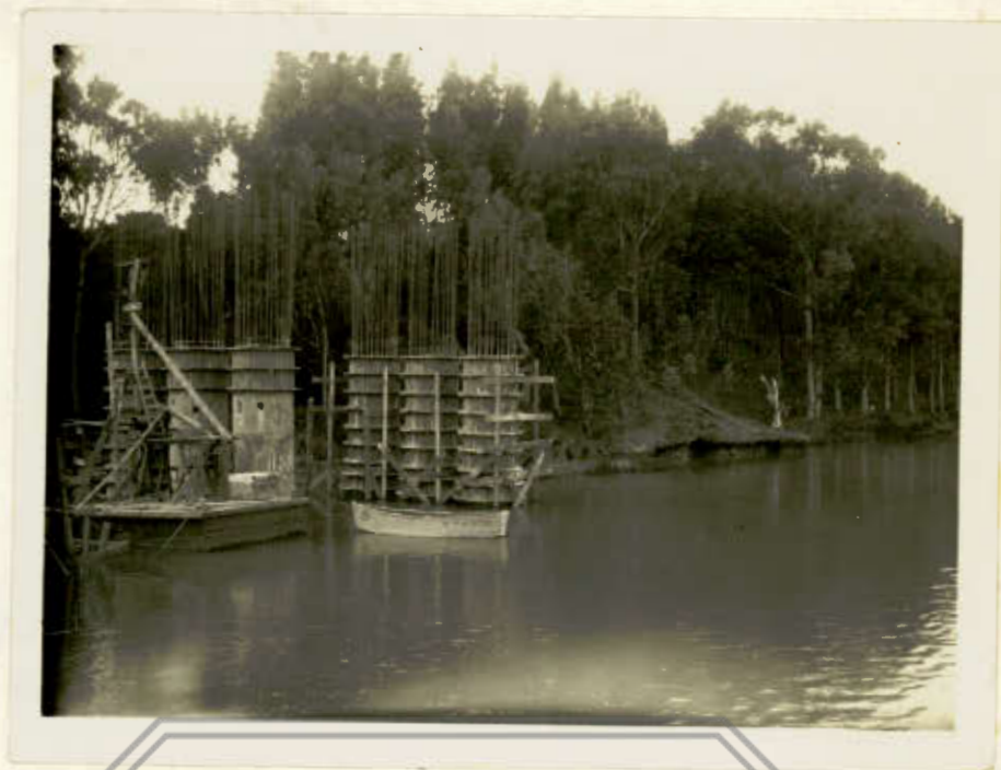
Construcción de las torres de fundación.
