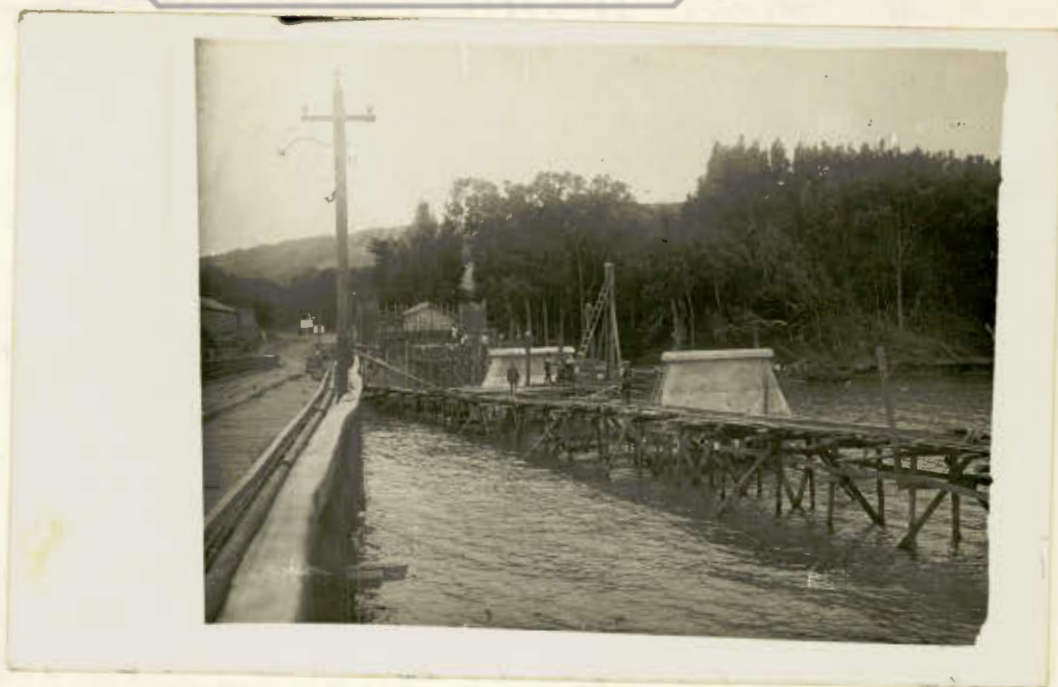
Construcción de las Cepas. La fotografía está tomada desde el puente de madera existente.
