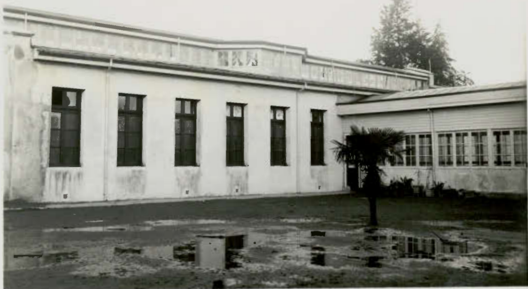
Escuela N° 1 de Cauquenes.- Reparaciones.-
