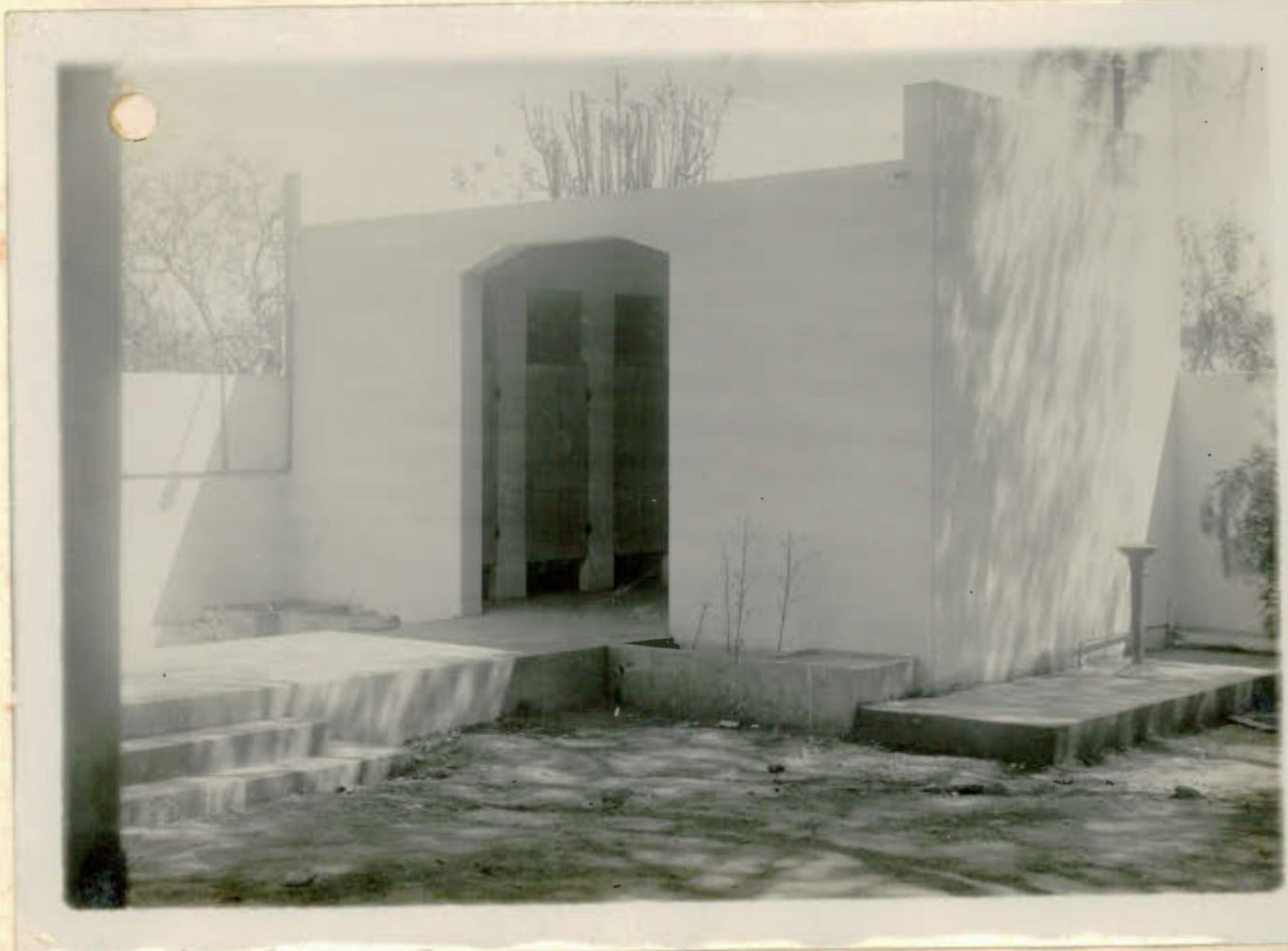
Pabellon de servicios higiénicos.
