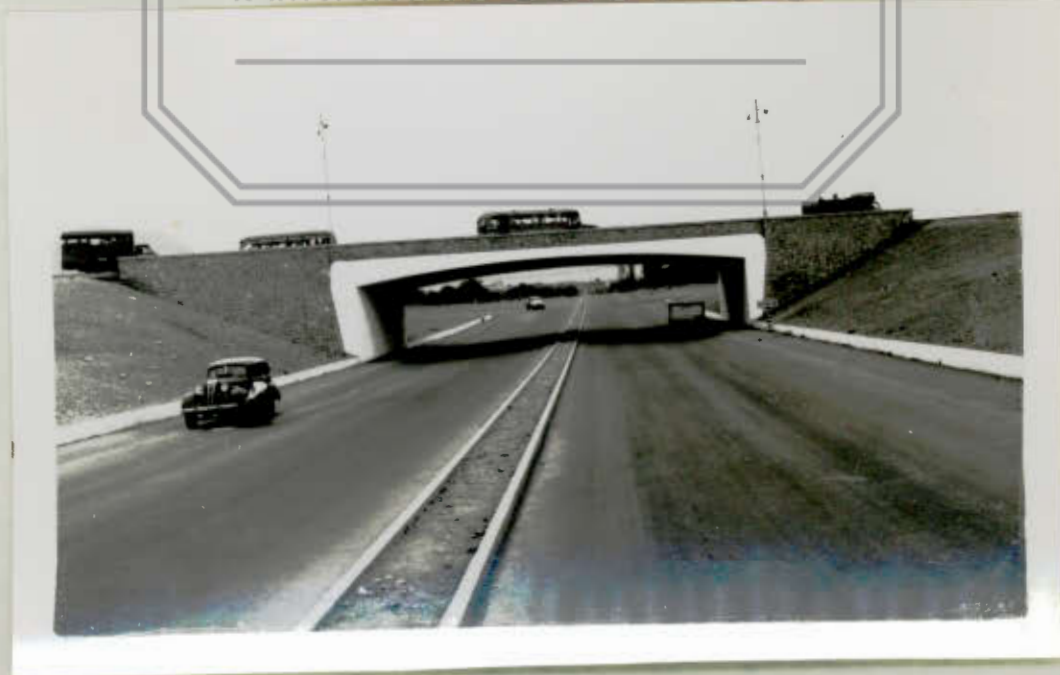
Carretera Lima-Ancón - Puente del Trébol
