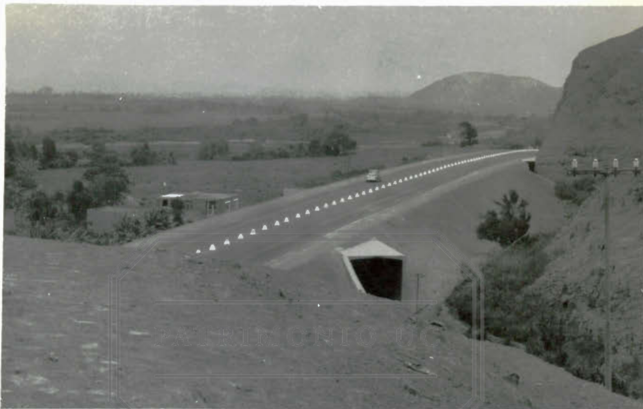
Carretera Lima-Ancón - Túnel Ferrocarril
