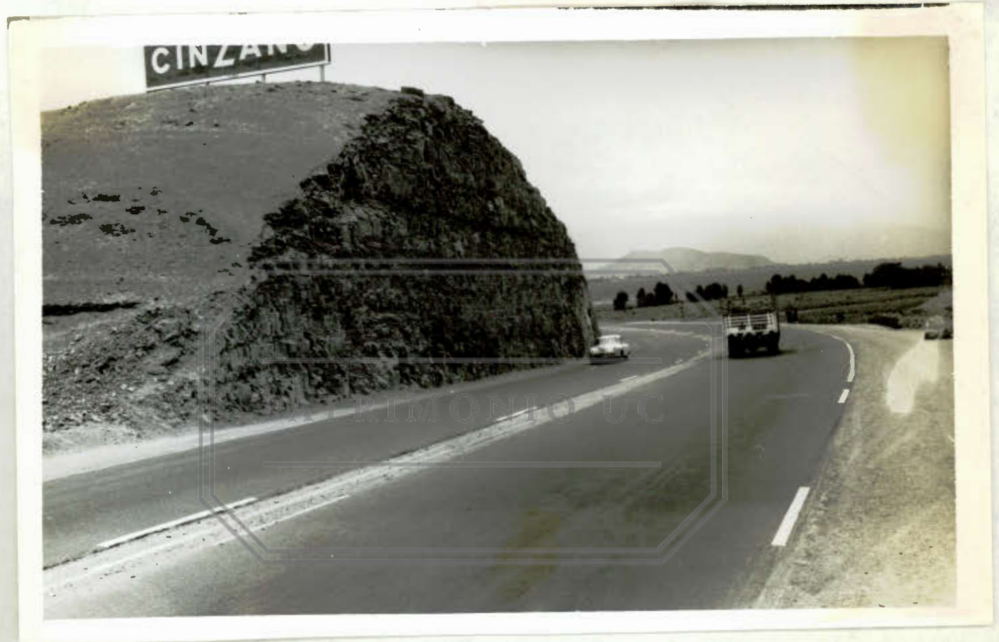
Carretera Lima-Acnón Km. 16 - Corte Gallinazos
