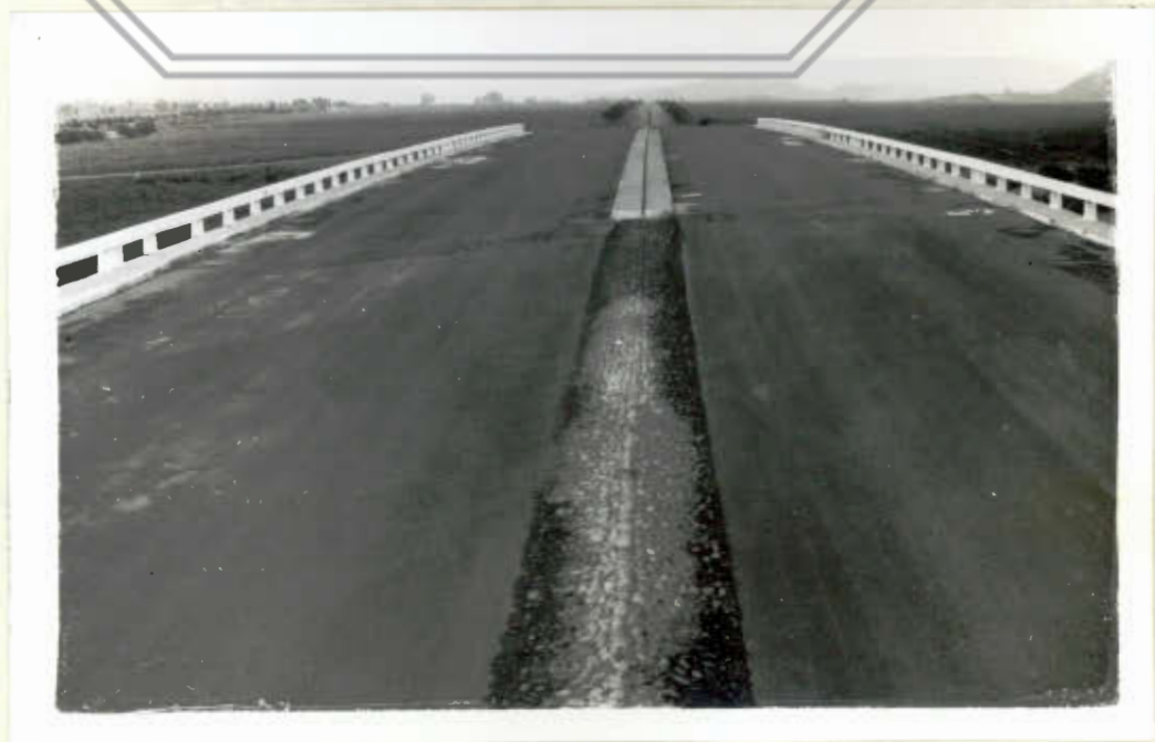
Carretera Lima-Ancón Km. 15 - Puente Chillón
