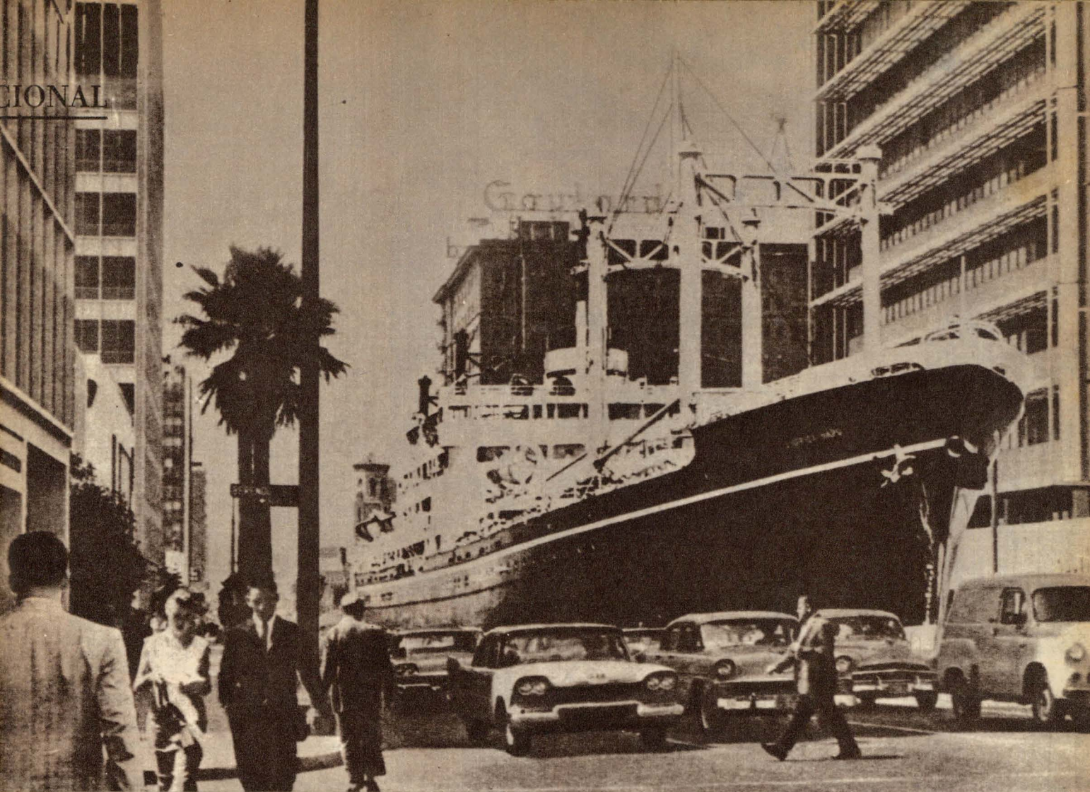
CALIFORNIA, PRIMER ESTADO. — Al final de 1962, California ha superado en habitantes a Nueva York, al aproximarse a los dieciocho millones. Esta nueva primacía abre para California posibilidades ilimitadas. Los Angeles, capital del Estado, de la cual damos esta fotografía, tiene ya siete millones de habitantes y se encamina hacia los once, extendiéndose por la costa del Pacífico desde Santa Bárbara hasta San Diego. La renta "per cápita" es superior en un veinticinco por ciento al término medio nacional. Los Angeles tiene el puerto artificial más grande del mundo y los buques avanzan hasta las calles de los rascacielos, como aquí se ve en la calle Wilshire Boulevard.
