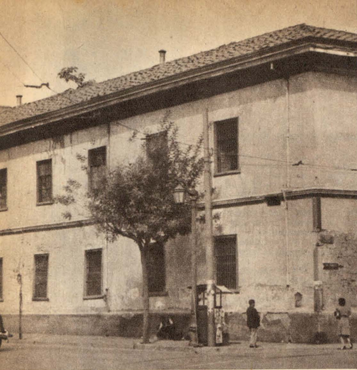
FACHADA del demolido Hospital San Juan de Dios, que se hallaba en la Alameda de las Delicias, de Santiago, esquina de la calle Santa Rosa. Ahora cuenta con un moderno edificio, en la Avenida Matucana.
