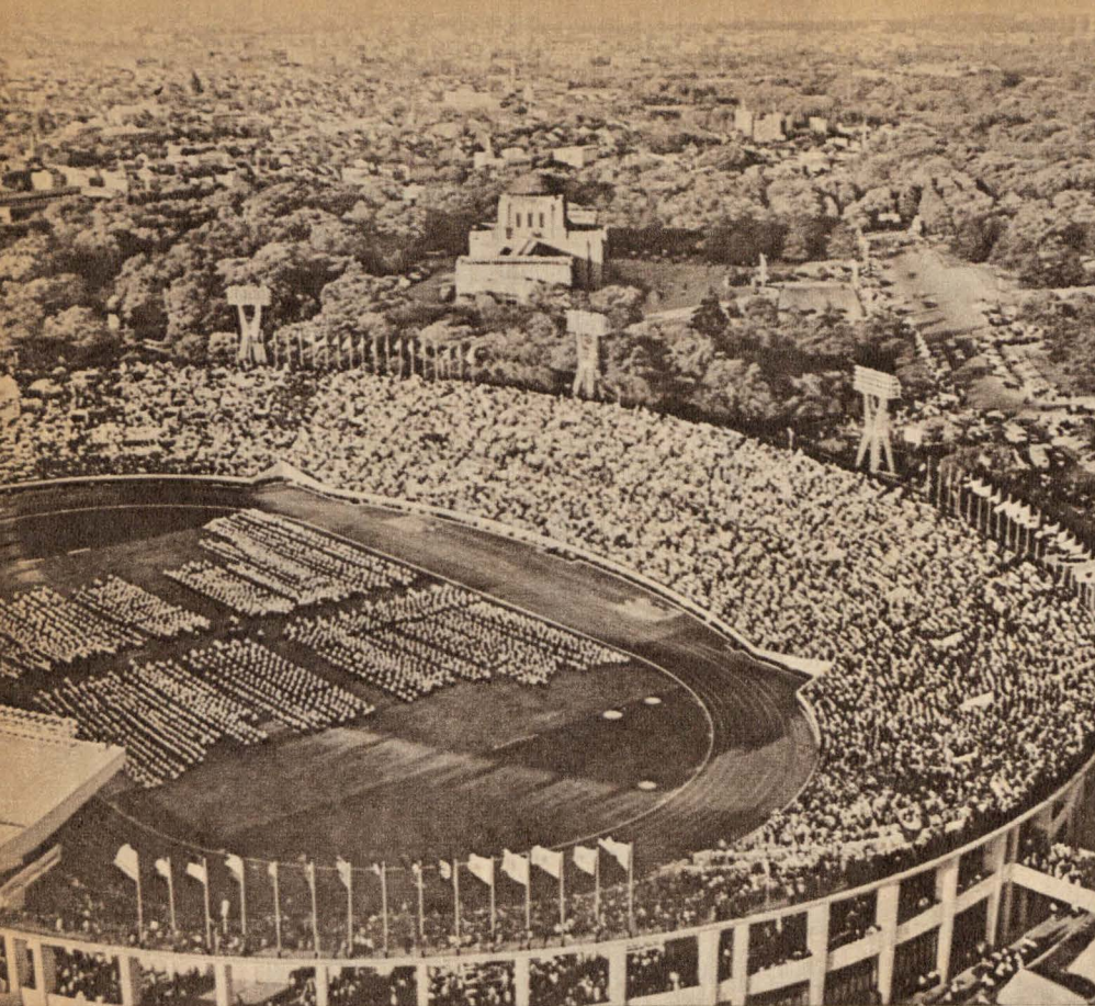
Vista aérea del monumental Estadio Olímpico de Tokio, sede de las próximas Olimpiadas Mundiales.
