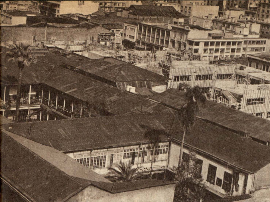
El viejo caserón del Instituto Nacional, en calle Arturo Prat. Al fondo, derecha, comienza a alzarse el nuevo edificio.
