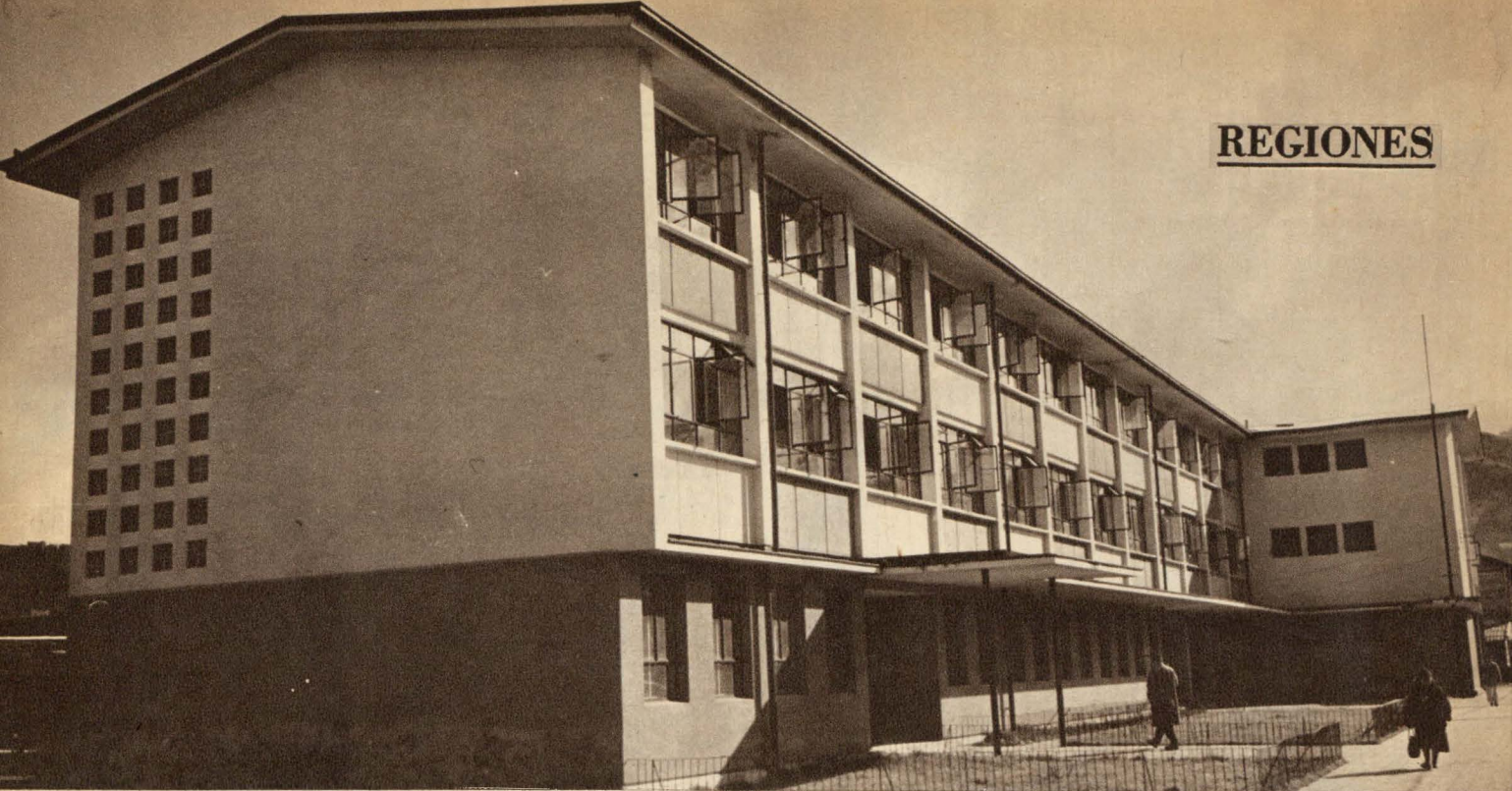
Pabellón "A" del Liceo de Hombres de Puerto Montt. En breve tiempo más se desea terminar los 2 pabellones restantes.
