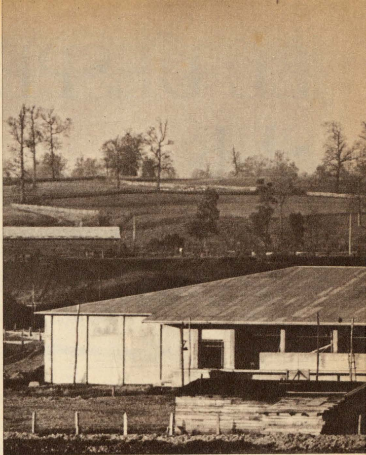
NUEVA PLANTA industrializadora de leche, que se levanta a tres kilómetros al noreste de Osorno. Tiene una capacidad inicial para el beneficio de 110 mil litros por día.
