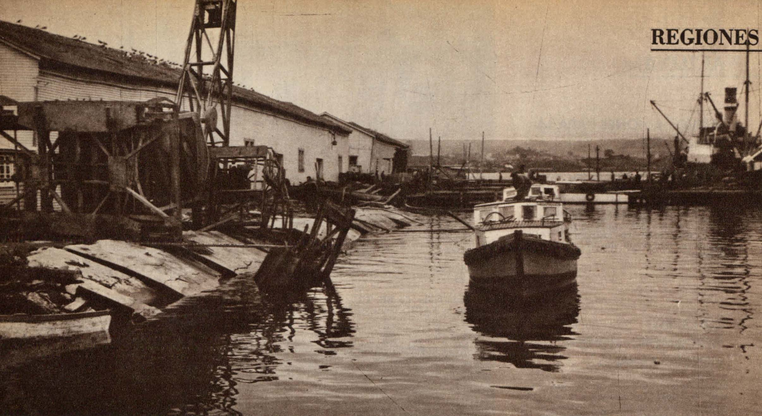
Puerto, muelles y bodegas de Angelmó, tal cual se encuentran en la actualidad. Pronto se dará comienzo a la reconstrucción de esas obras.
