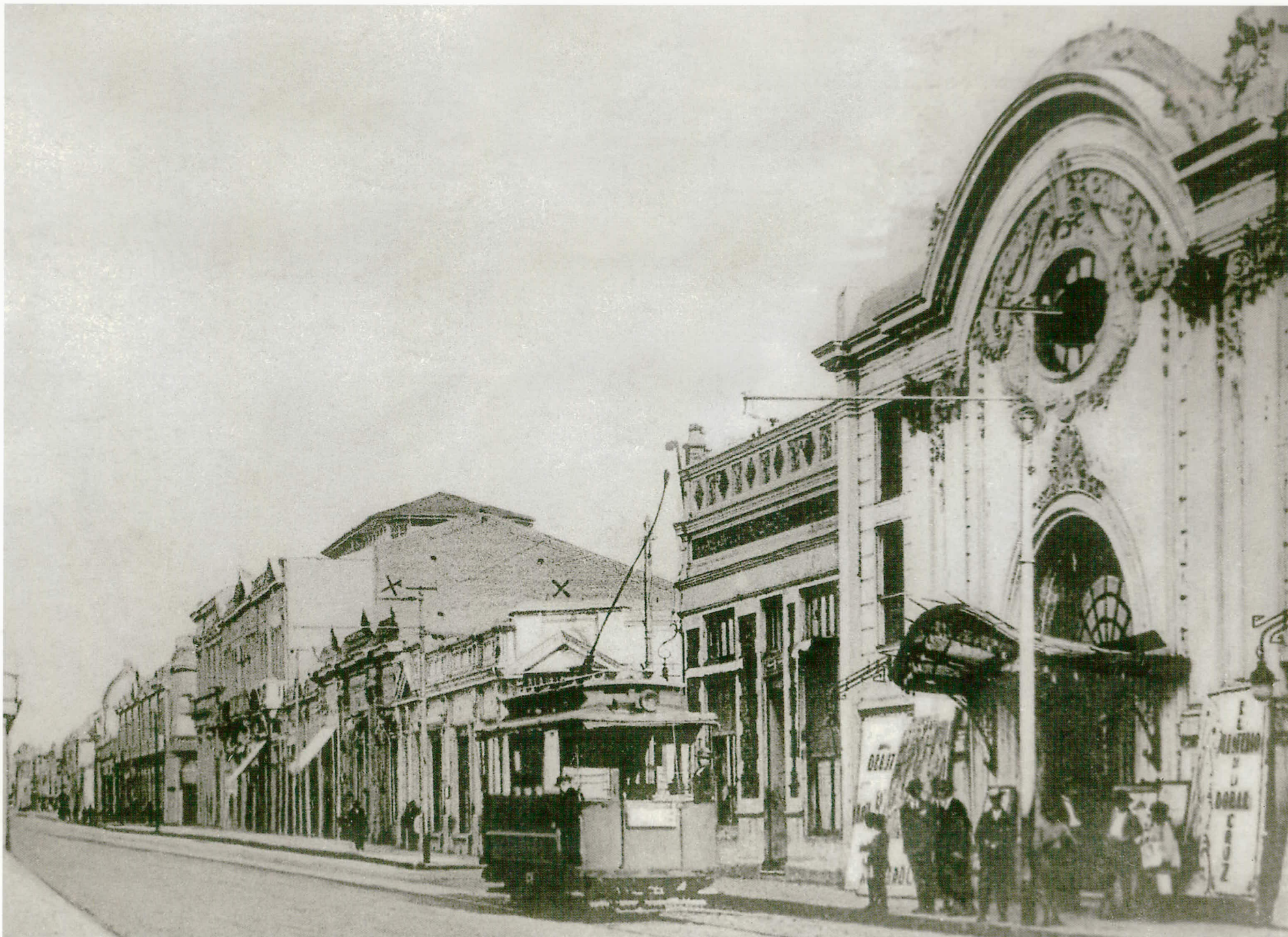
Talca, intersección de calles Uno Sur y Dos Oriente.
